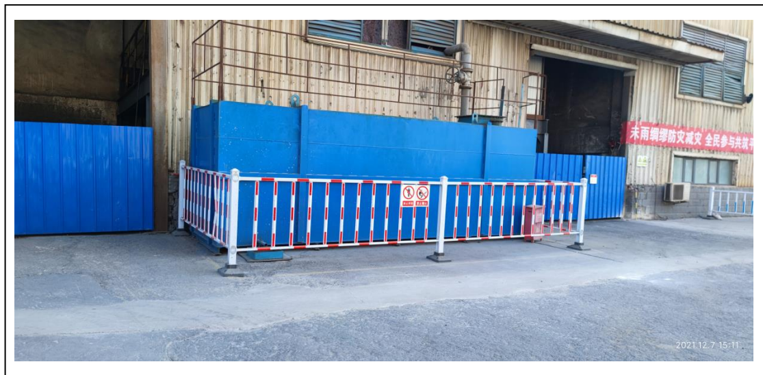
图 4.1-6 应急收集设施
