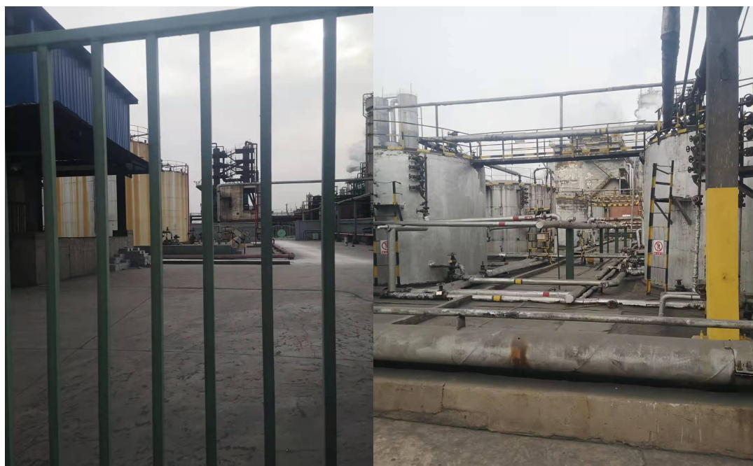
焦化厂粗笨罐区
