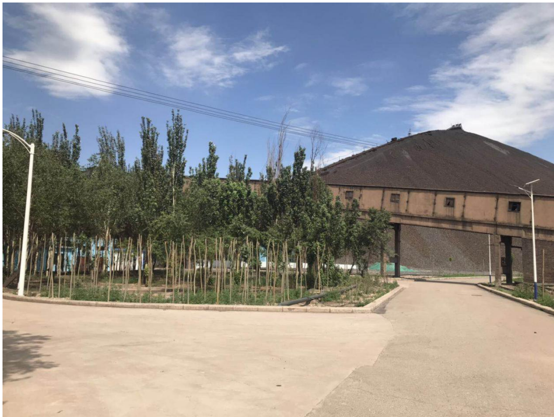
图 3-17 选矿厂废石山现状
