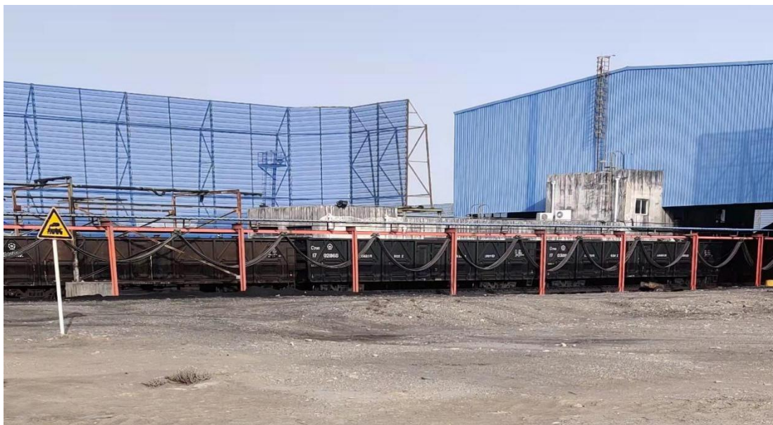
图 3-15 铝电煤料场现状
