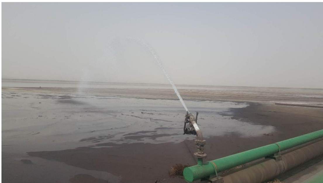
尾矿坝每日进行安全检查，分时段记录尾矿库运行记录。
