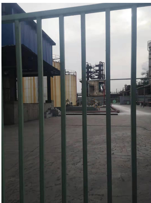
焦化厂粗笨罐区
