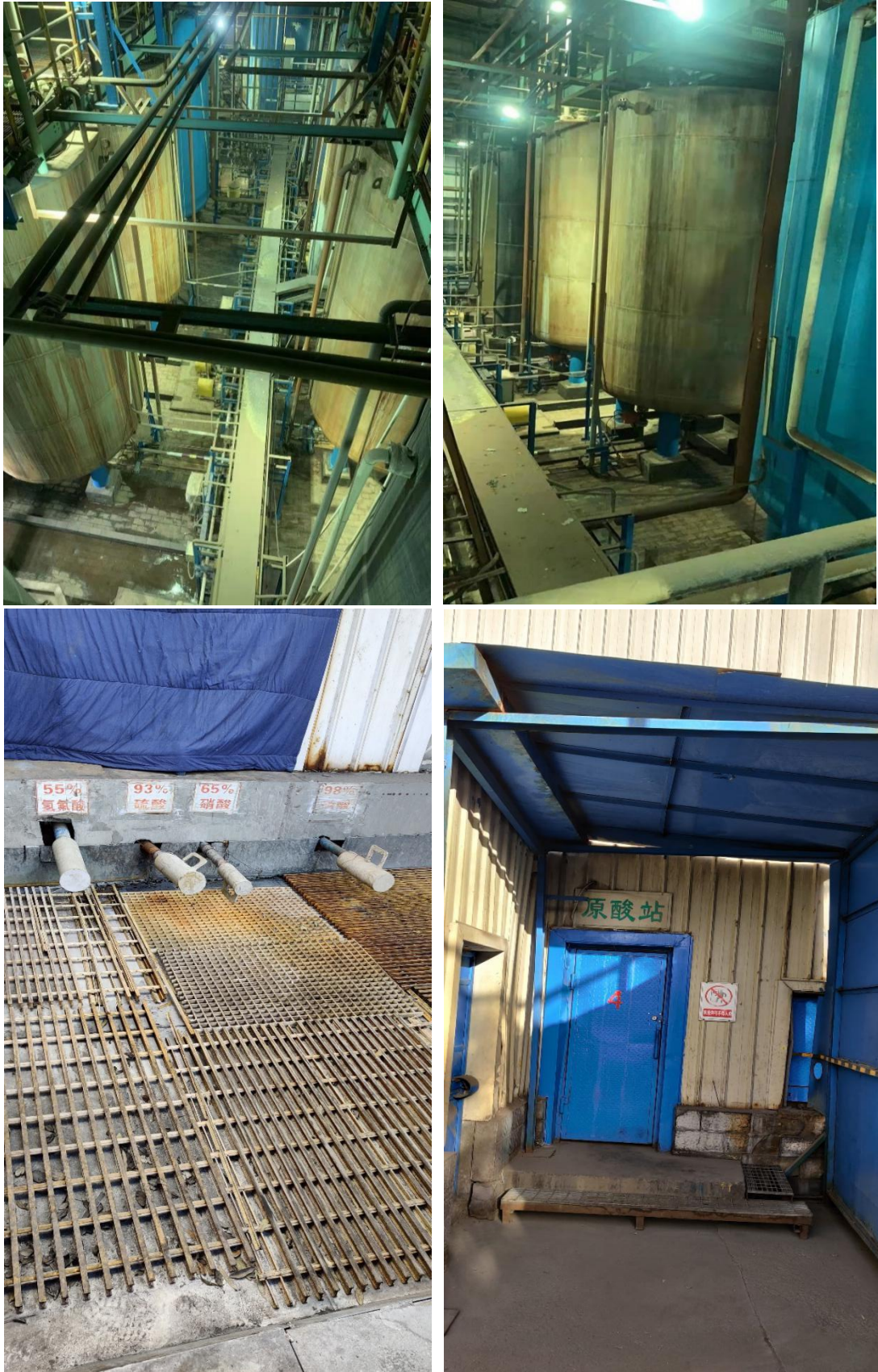
图 3-4 不锈钢厂区原酸站储罐区及装卸点
