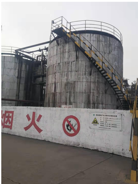
焦化厂焦油储罐
