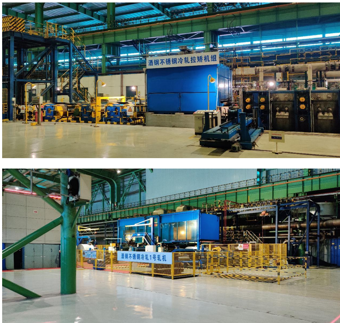
图 3-27 不锈钢厂厂内主要设备
