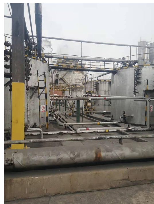
焦化厂综合槽区
