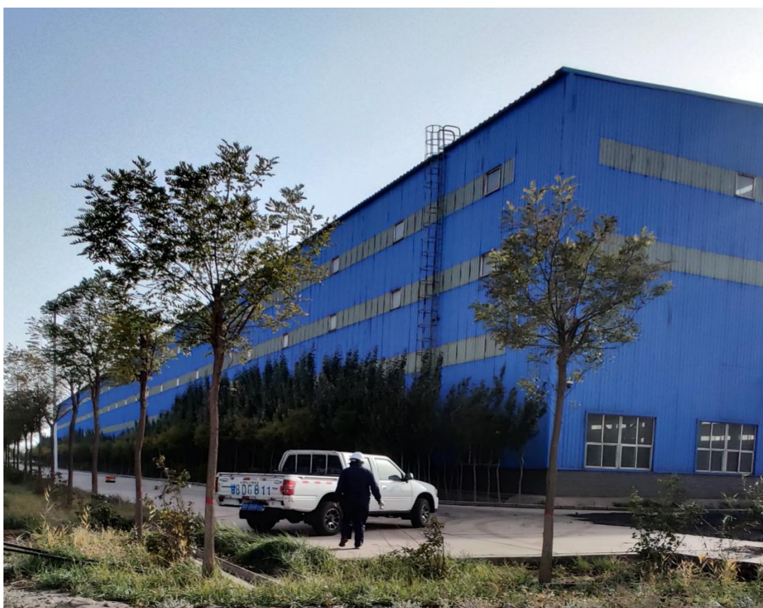
图 3-18 危废暂存库现状
