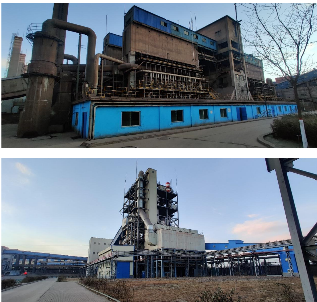
图 3-23 选矿厂厂内主要设备
