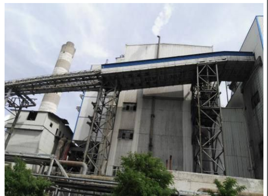
燃煤输送廊道
