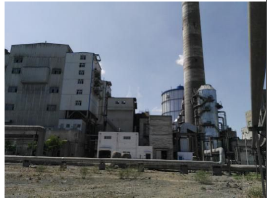
脱硝改造区域
