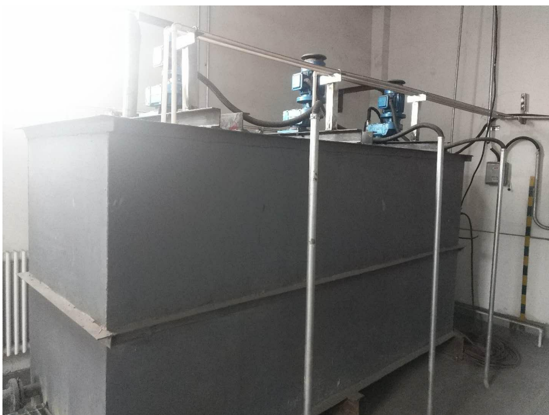
脱硫废水中和-反应-絮凝三联箱
