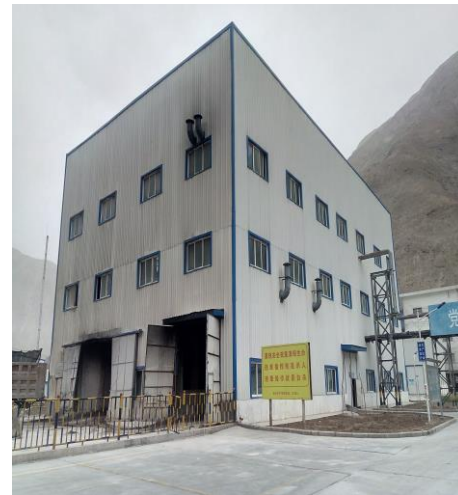
尾矿过滤厂房外部
