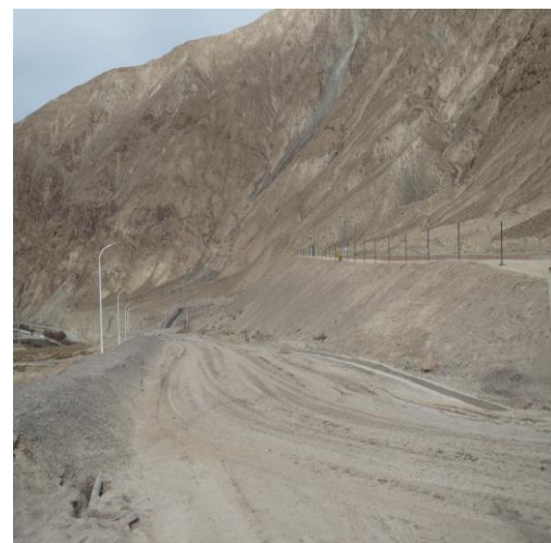
尾矿运输道路
