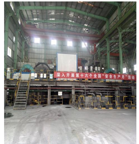
磨矿车间内部
