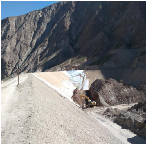
初期坝铺膜防渗
