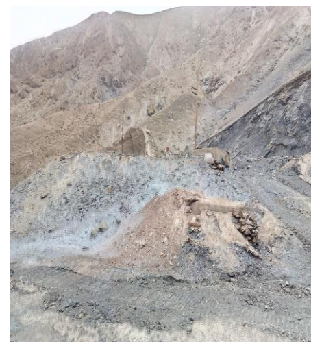
新水高位水池
