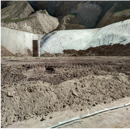
北侧山坡铺膜防渗
