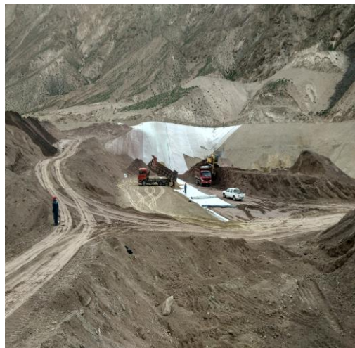
库底铺膜防渗
