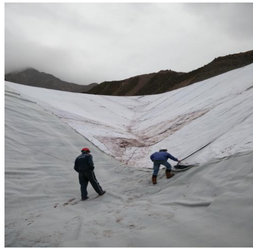
南岸铺膜防渗
