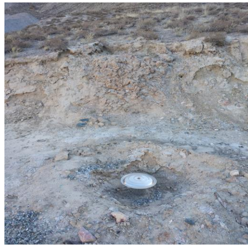
3#地下水监测井
