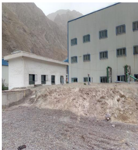
1000m 3 循环水池
