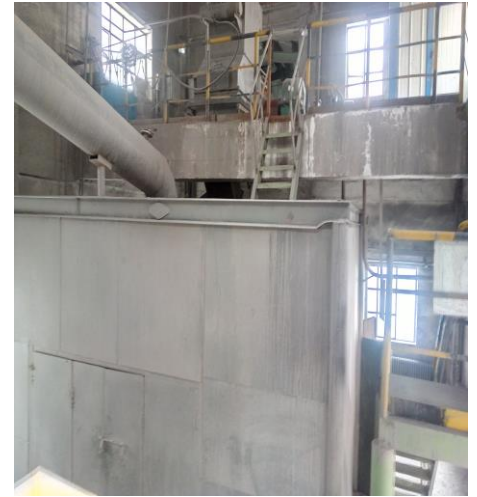
筛分车间内部
