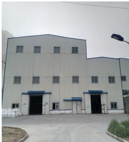
磨浮车间外部
