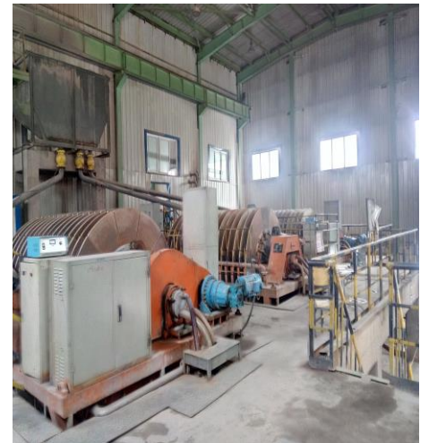
尾矿过滤厂房三层平台
