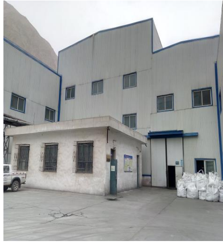
精矿浓缩过滤厂房、调度室
