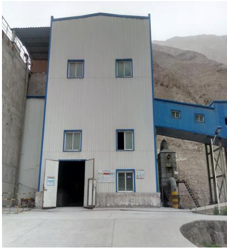
破碎车间外部
