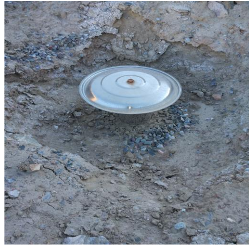
1#地下水监测井
