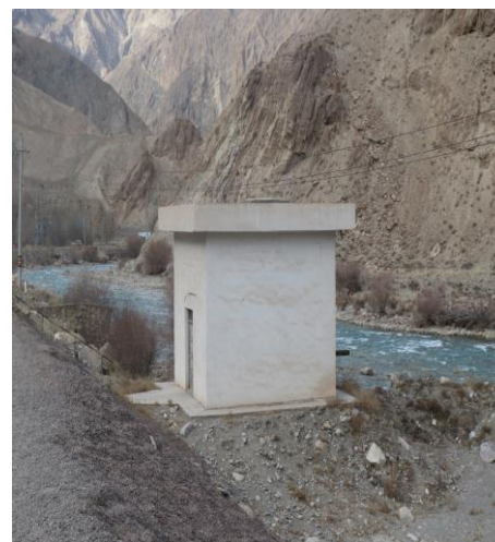
工业水源井泵房
