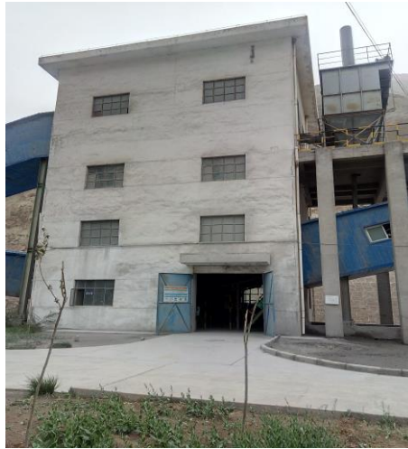
筛分车间外部
